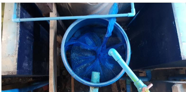
ภาพที่ 27 : ภาพแสดงถุงทรายในถังระบบกรองของสถานแสดงพันธุ์สัตว์น้ำราชวมงคลตรัง
