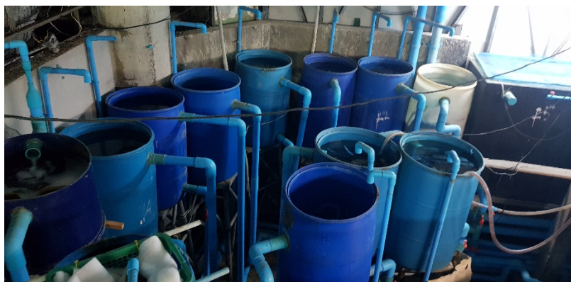
ภาพที่ 26 : ภาพแสดงถังระบบกรองในสถานแสดงพันธุ์สัตว์น้ำราชวมงคลตรัง
